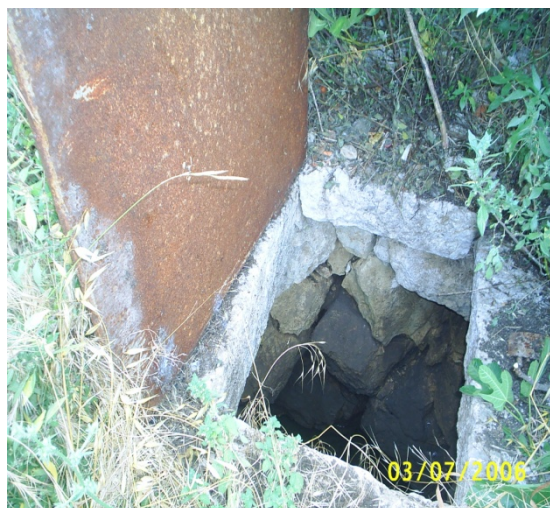
Slika 1. Otvor kopanog bunara
